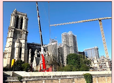
横から見たノートルダム大聖堂。木製屋根を囲む足場や大型移動式クレーンが確認できます。
